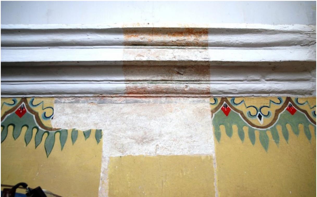
Radzymin, kościół par. pw. św.św. Piotra i Pawła, prezbiterium, ściana południowa, górna część okna z fragmentarycznie zrekonstruowanym detalem zdobniczym i gzymsem koronującym z pasem polichromii, 1. poł. XVI w. albo po 1767, wyk. niezidentyfikowany malarz regionalny, fot. MW, 2017
