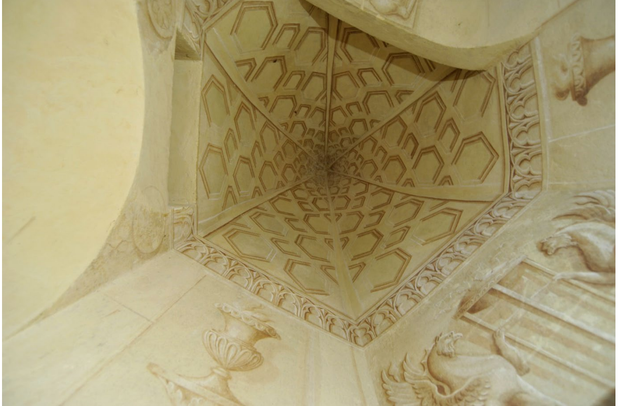
Arkadia, pawilon Świątynia Diany, pomieszczenie ofiarne, widok ogólny sklepienia kopulastego, fot. MW, 2016.
