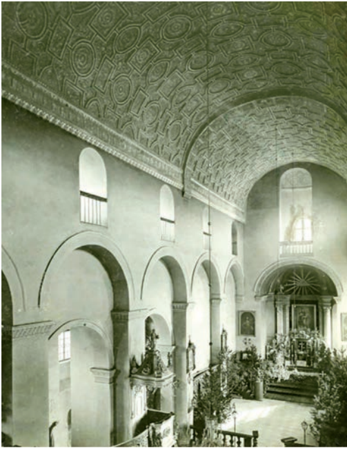
Brochów, kościół św. Jana Chrzciciela i św. Rocha, nawa główna w kierunku prezbiterium przed zniszczeniem kościoła, zdjęcie archiwalne; Z. Rokowski, Obronny kościół w Brochowie i jego odbudowa , „Ochrona Zabytków Sztuki”, cz. I, (1-4/1930–31), s. 108
