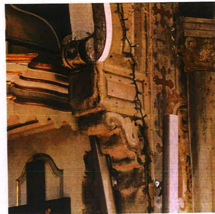
Il. 10. Kościół św. Apostołów Piotra i Pawła w Skutumpah. Fragment empory – płótnem obito profilowany wspornik. Fot. Małgorzata Korpała
