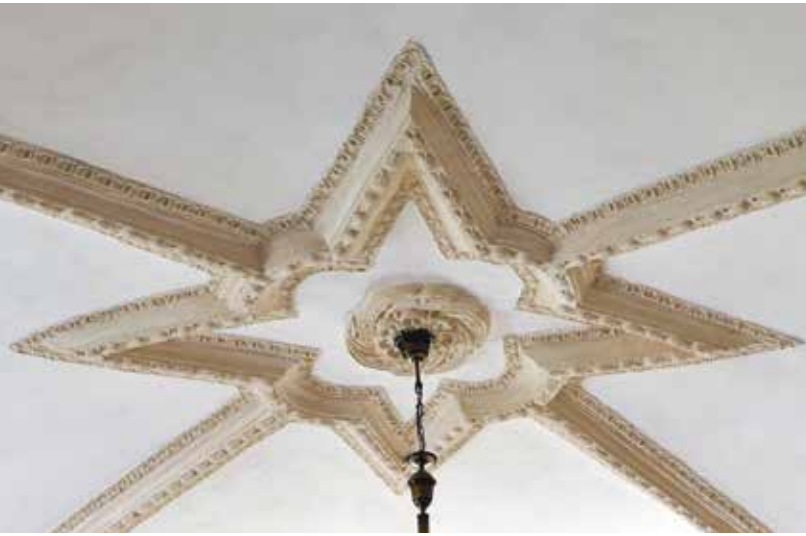
Chrzęsne, willa Stefana Dobrogosta Grzybowskiego, parter, pokój, fragment sklepienia krzyżowego z centralną rozetą gipsatorską, 1635 r., proj. Tommaso Poncino (atryb.), stan z 2018 r.
