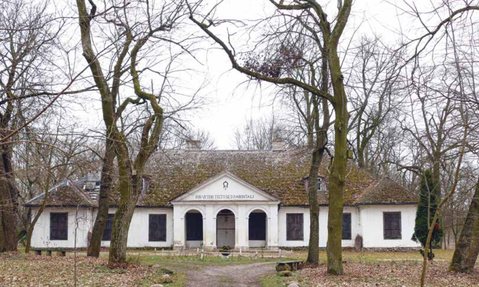
Nowa Sucha, alkierzowy dwór Cieszkowskich, elewacja frontowa, 1743 r., fot. z 2019 r.
