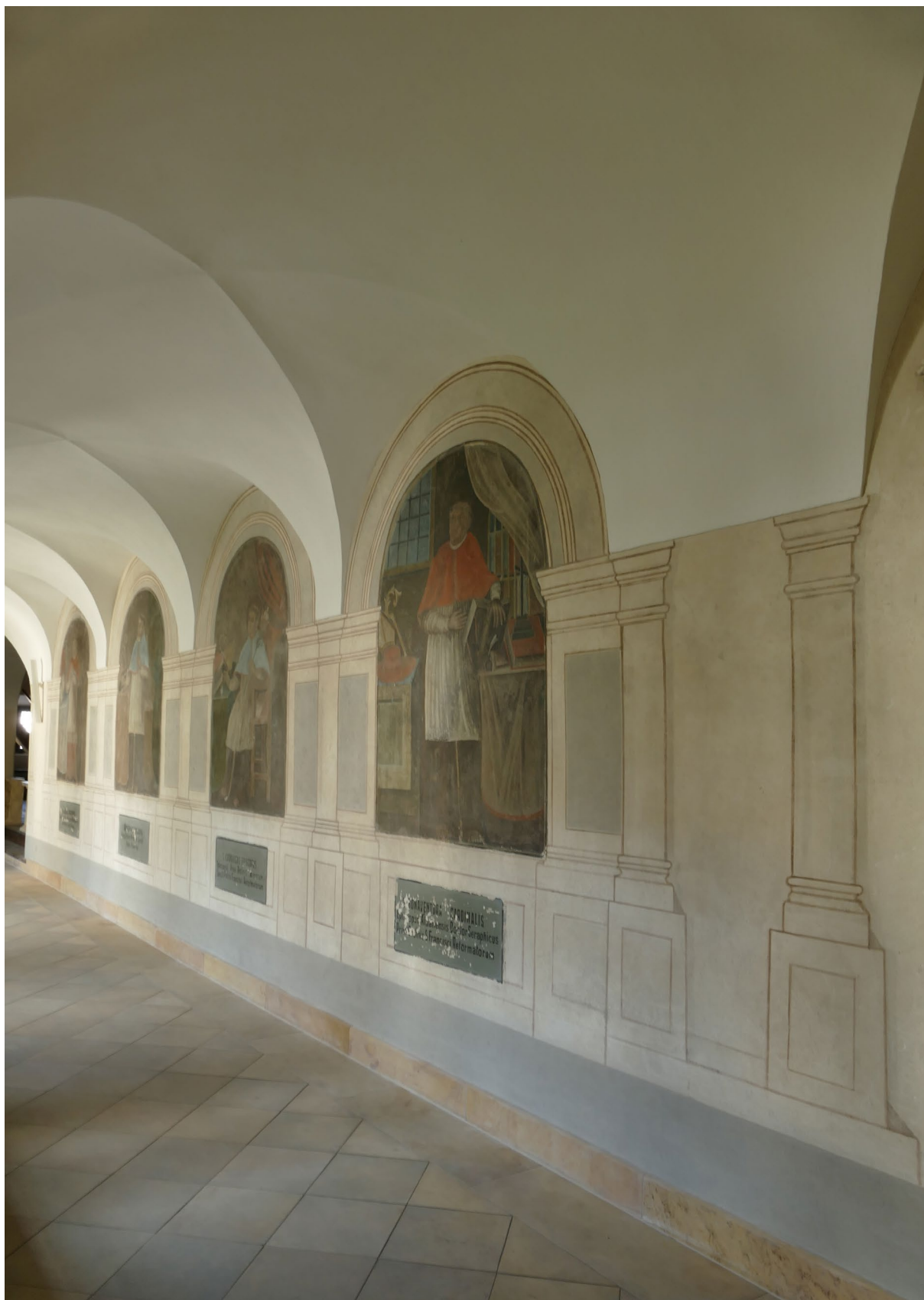
Węgrów, klasztor franciszkanów-reformatów (ob. plebania, ośrodek ekumeniczny i szkoły katolickie), parter, krużganek, widok ogólny na skrzydło południowe, malatury, 1771 i 1790 (?), fot. MW, 2018.
