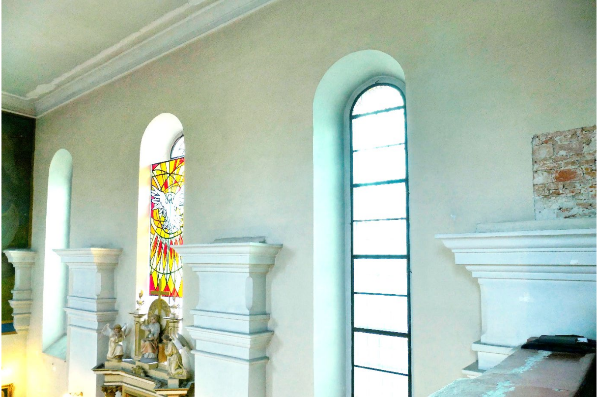
Warka, kościół parafialny pw. św. Mikołaja, nawa główna, ściana południowa, odkrywka z dwiema fazami dekoracji malarskiej – zacheuszki, 2. poł. XVII w. (?) – XVIII w., wyk. nieustalony warsztat lokalny (?), fot. MW, 2017
