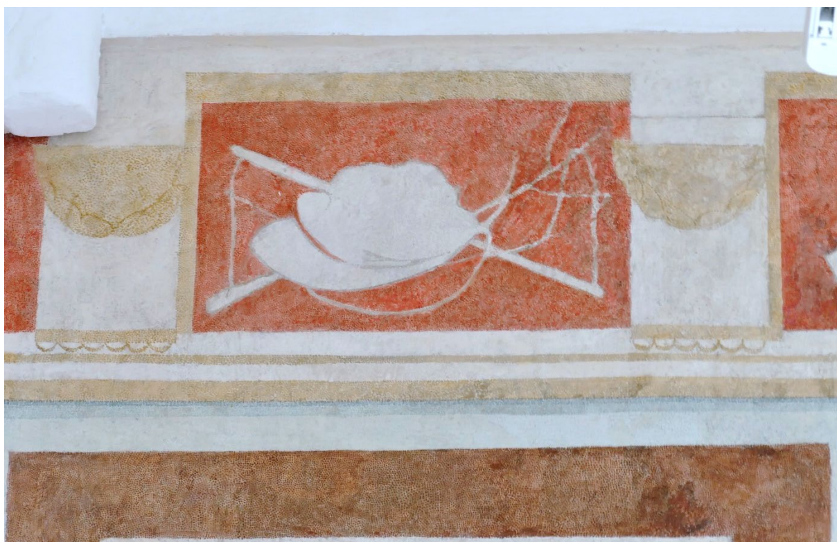
Szydłowiec, zamek, skrzydło północne, piano nobile , pokój z dekoracją wczesnoklasycystyczną z pasem metop z panopliami, 4. ćw. XVIII lub pocz. XIX w., polichromia architektoniczno-ornamentalna, wyk. nieustalony warsztat z Warszawy (?), fot. MW, 2016
