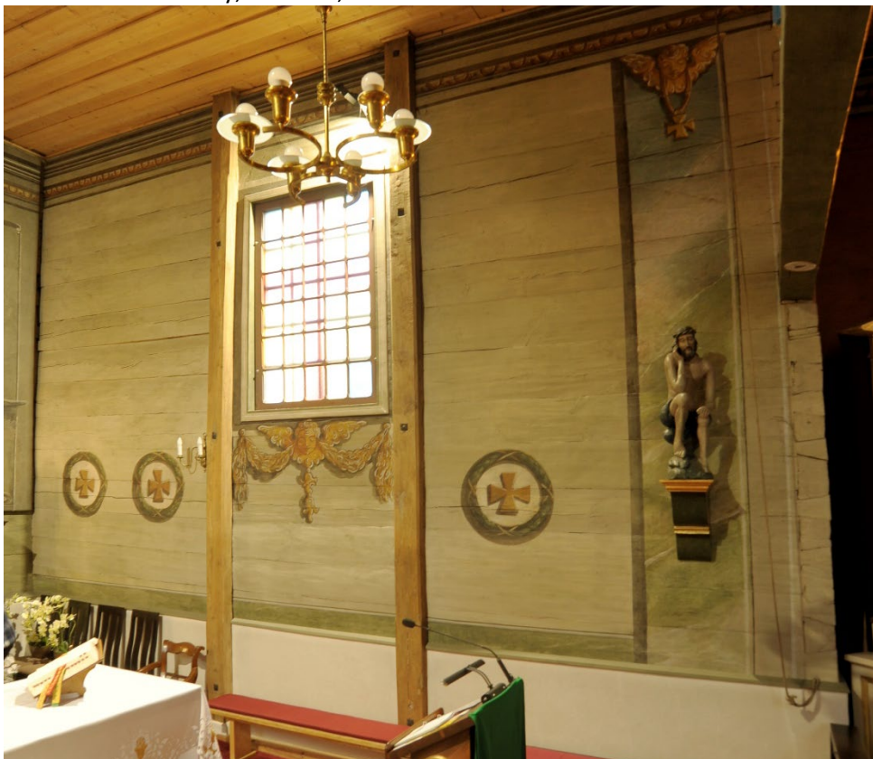
Kurdwanów, kościół par., widok ogólny ściany południowej prezbiterium, 4. ćw. XVIII w., proj. i wyk. nieustalony warsztat lokalny, fot. MW, 2018.
